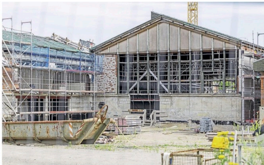
Nach monatelanger Pause sollen die Arbeiten am Kulturhaus jetzt endlich weitergehen.
